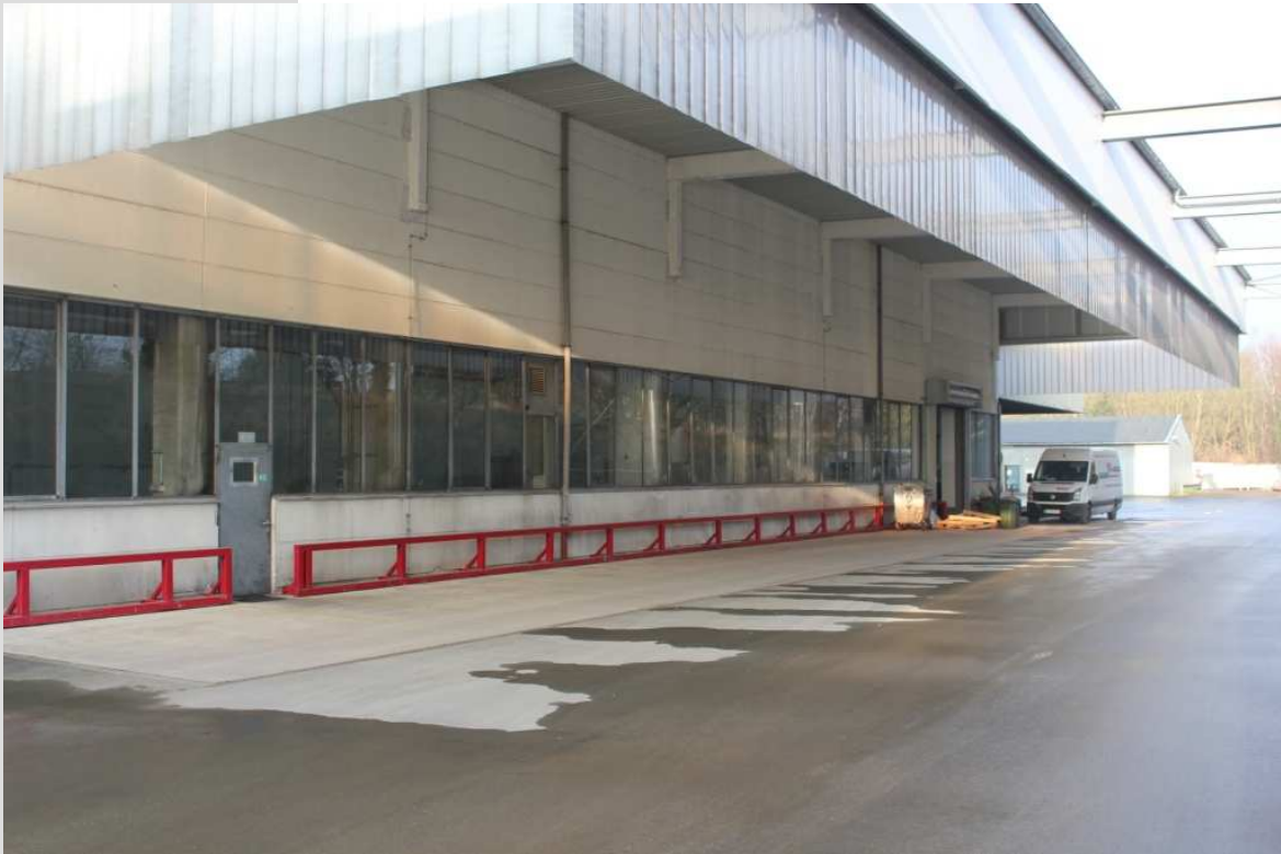
Halle 4 Überdachtes Freilager
